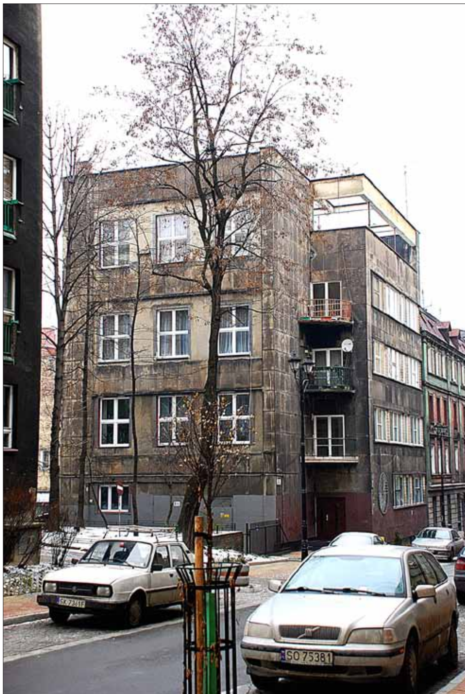
Fot. 4. Widok istniejącego skrzydła mieszkalnego
